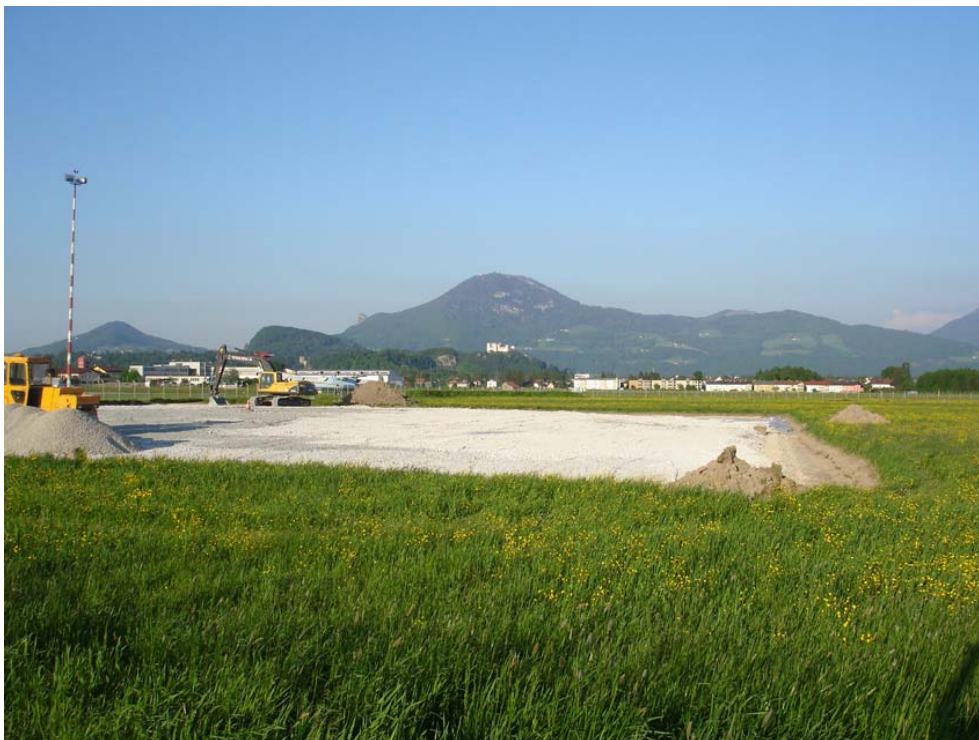
Abb.2: Abstellfläche Im Grünland Außerhalb des Flughafen- geländes
