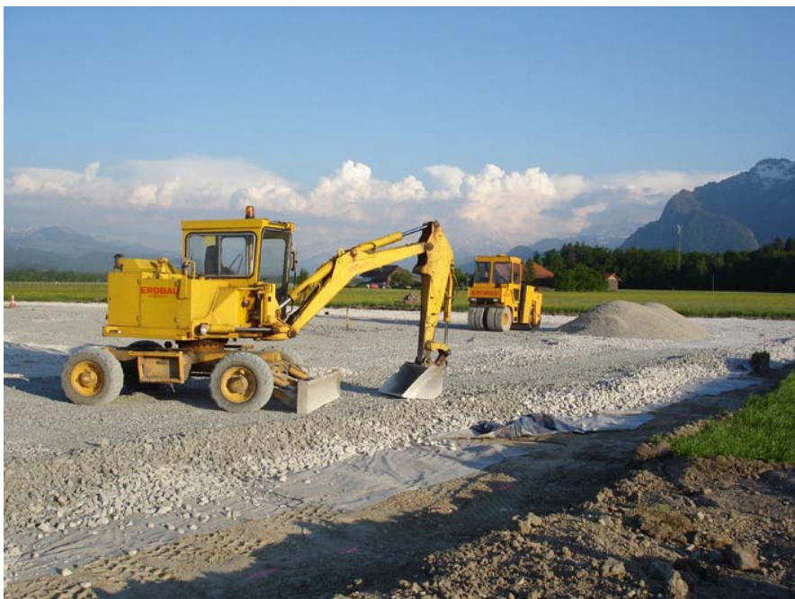
Abb. 3: Aufbau mit Vlies und Schotter
